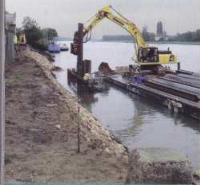
Restauration des garde-corps de pont-écluse métallique de Neuzy.
