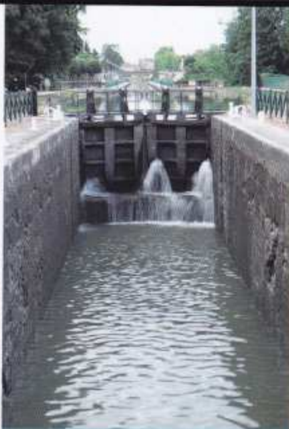
Bajoyers perforés de l'écluse du pont-canal de Digoin.
