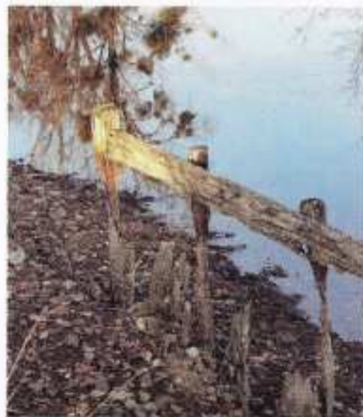
Série de palplanches en bois posées le long du canal du Centre.
